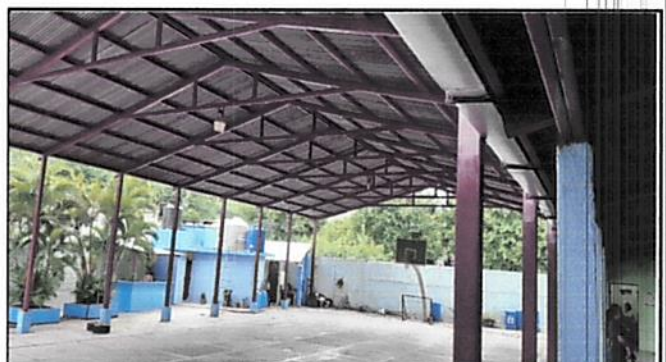
Foto 4: Sustitución de baja de agua pluvial de metal por tubo PVC "3"
