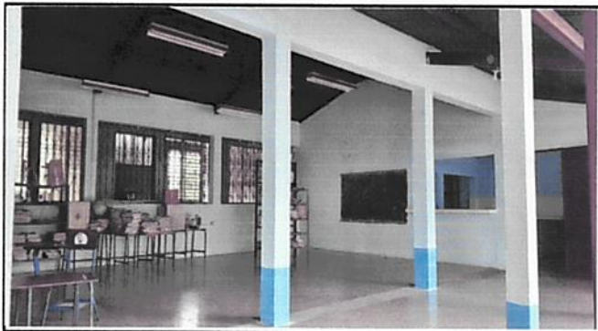
Foto 3: Cerramiento de muro para expansión de puertas y extracción de ripio
