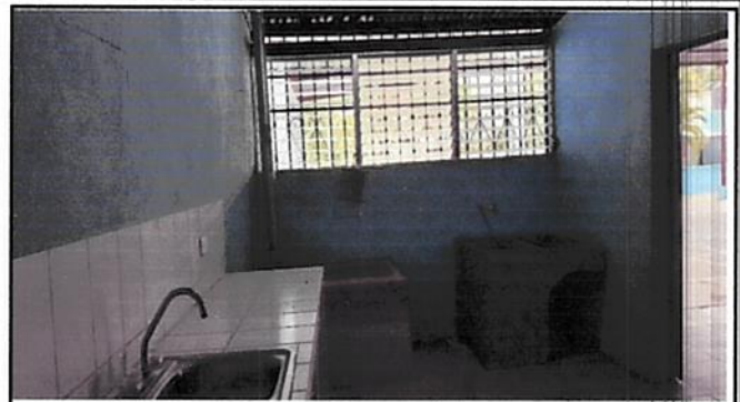
Foto 2: fabricación e instalación de ventana en cocina
